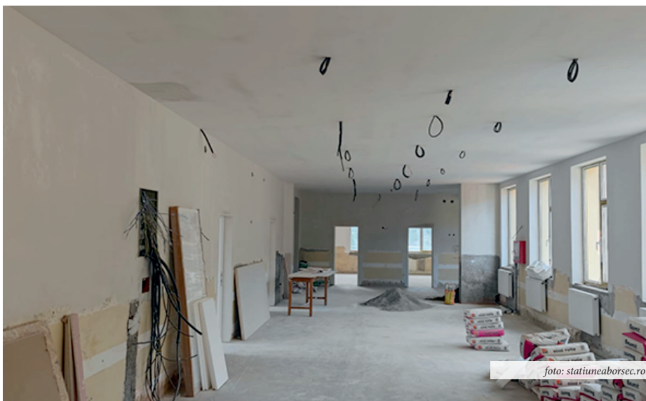
Urmează să fie executată vopsirea interioară, montarea parchetului și a panourilor de perete în diferitele incinte ale clădirii
